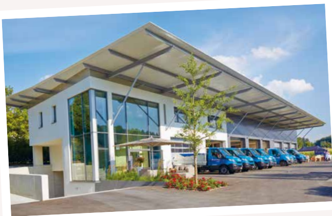
Die Räumlichkeiten in Dättwil sind zu eng geworden. 2016 konnte der Gartenbau den neuen Werkhof in Fislisbach beziehen.
