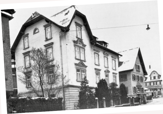
In diesem Gebäude an der Mellingerstrasse in Baden nahm Traugott Schoop am 1. Januar 1955 den Betrieb als Schoop + Co., vormals Josef Kaufmann, auf.
